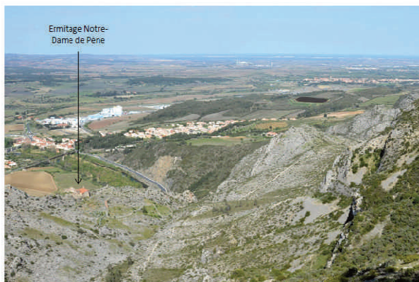
• Photographie 75 : Photographage du projet vu depuis les hauteurs dominant l'hermitage
